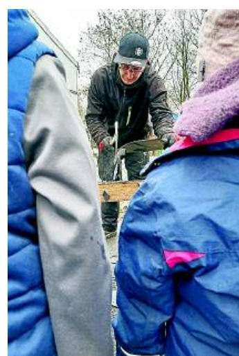
Interessiert schauen die Kinder dem Dachdecker bei der Arbeit zu.
